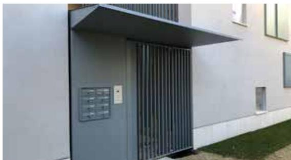
Opere da fabbro di finitura elevata quali parapetti per balconi ad aste, in cristallo temperato e in lamiera taglio laser. Pergolati architettonici di finitura dei terrazzi, pareti a canniccio metallico, cancelli e pensiline. Tutte le opere zincate a caldo e verniciate a polveri di poliestere.
