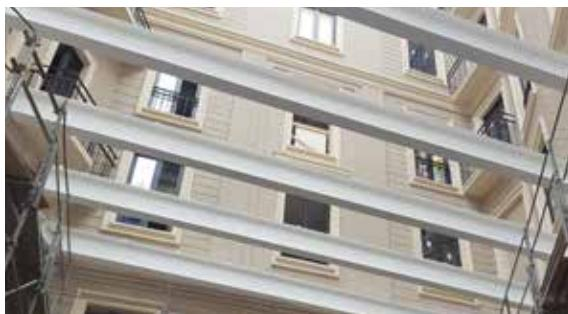
Carpenteria metallica strutturale in acciaio sabbato e primerizzato per la finitura intumescente: rinforzi strutturali e antisismici per la realizzazione di tutti i nuovi solai interni. Nuova struttura di sostegno del lucernario al piano terra a copertura della corte interna.
