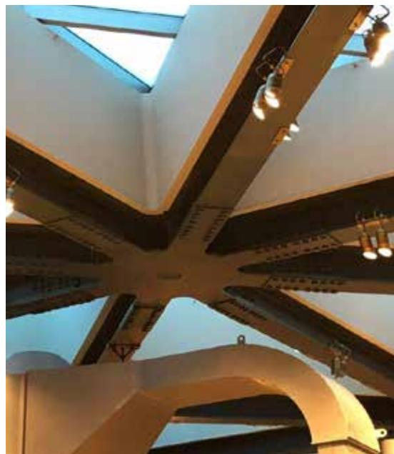
Carpenteria metallica strutturale in acciaio sabbato e primerizzato per la finitura intumescente completa di rinforzi strutturali e antisismici per la realizzazione dei nuovi solai interni. Nuova struttura precaricata di sostegno del lucernario al piano terra nei locali ad uso commerciale di nota catena del mondo della caffetteria. Finiture e opere a cura del fabbro annesse.
