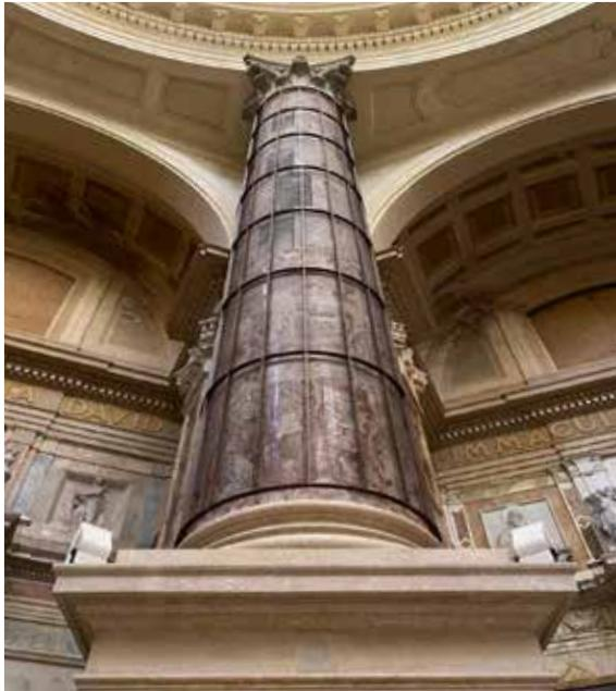
Carpenteria metallica leggera in acciaio inox Aisi316 con verniciatura a polveri di poliestere per la messa in sicurezza del colonnato in pietra naturale della Nuova Basilica.
