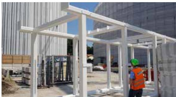
Carpenteria metallica strutturale in acciaio sabbettato e primerizzato per la finitura intumescente a realizzare un castello ascensore duplex e ripartizioni interne all'edificio. Parapetti e finiture architettoniche a corredo quali recinzioni, scale, cancelli e colonnato del percorso pedonale coperto.
